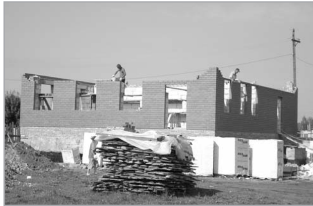
Строительство медресе идет полным ходом
